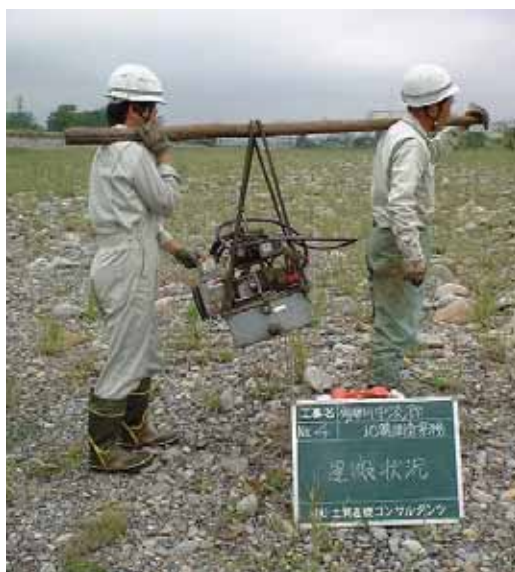
b) 機械解体後、人力による資機材運搬
