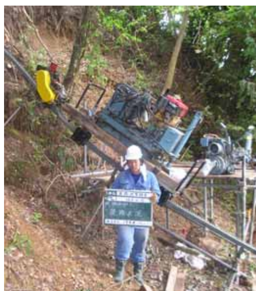
c) モノレールによる資機材運搬
