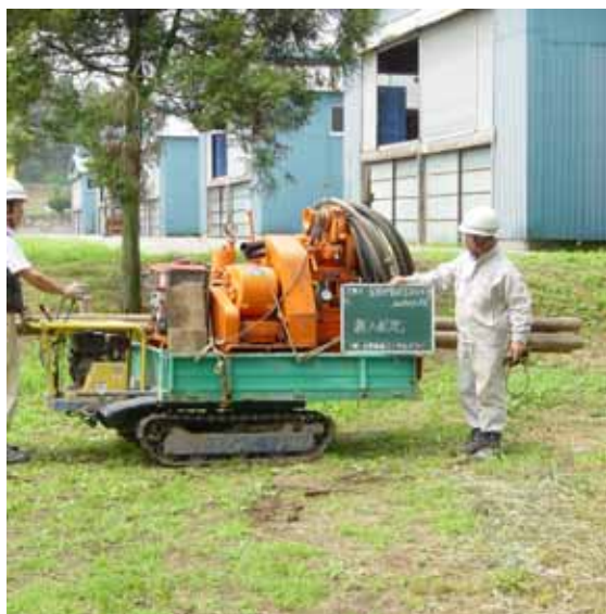
a) 不整地運搬車（小型キャリアダンプ）による資機材運搬
