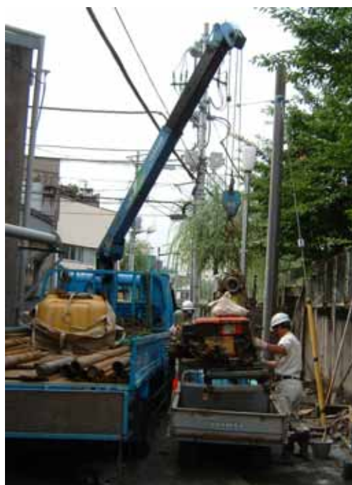
小型クレーンによる吊り降ろし状況
